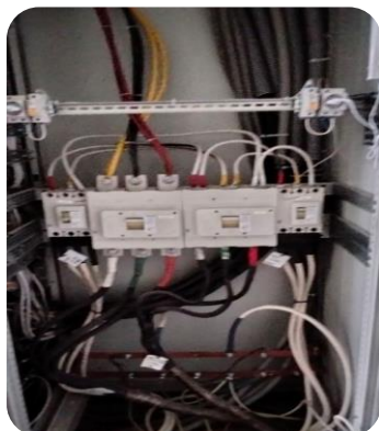
Монтаж оборудования электрощитовой (вводно - распределительного устройства, монтаж двух шкафов управления автоматического ввода резервного питания)
