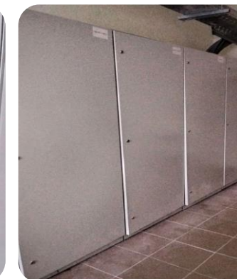
Монтаж оборудования электрощитовой (вводно - распределительного устройства, монтаж двух шкафов управления автоматического ввода резервного питания)
