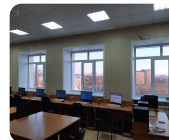
Замена окон 1 и 4 этажей в кабинетах № 3.117, 3.422, 3.424 и 5 этажа корпуса
