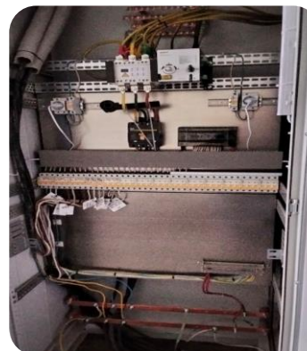
Монтаж оборудования электрощитовой (вводно - распределительного устройства, монтаж двух шкафов управления автоматического ввода резервного питания)
