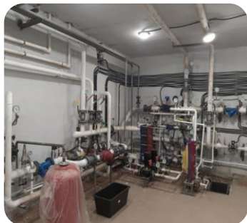
Капитальный ремонт системы розлива отопления, помещения теплового узла № 3.014 и помещения водомерного узла № 3.003
