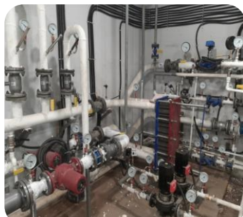
Капитальный ремонт системы отопления, вентиляции, узла учета тепловой энергии. Автоматизация сантехнических систем
