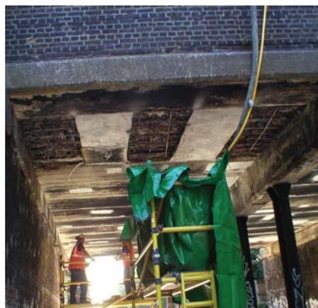
Рис. 2. Восстановленные и дефектные участки пролетного строения
