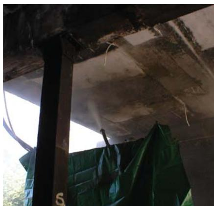
Рис. 1. Установка для «сухого» набрызгбетонирования (фото слева); процесс нанесения фибронабрызгбетона на поврежденную часть пролетного строения (фото справа)
