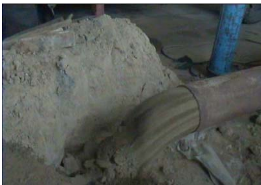
Рисунок 1. Выход порции грунта в виде псевдопоршня
