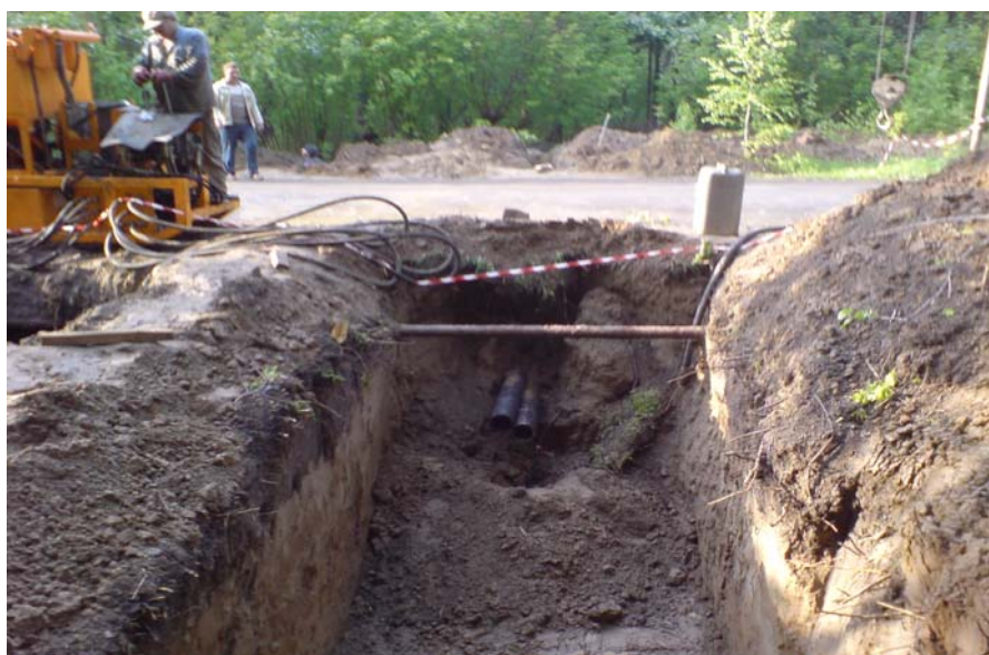
Рисунок 3. Каналы под силовой электрический кабель, проложенные методом «сухого» бурения в парке г. Новосибирска
