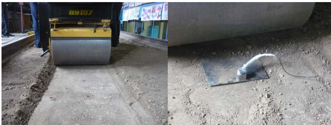
Рисунок 2. Испытания в грунтовом канале
