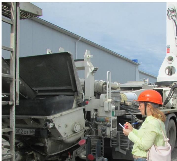
Рисунок 3.13 – Фрагмент натурных наблюдений фиксирования отгрузки бетона в приемный бункер SCHWING S 42 SX
