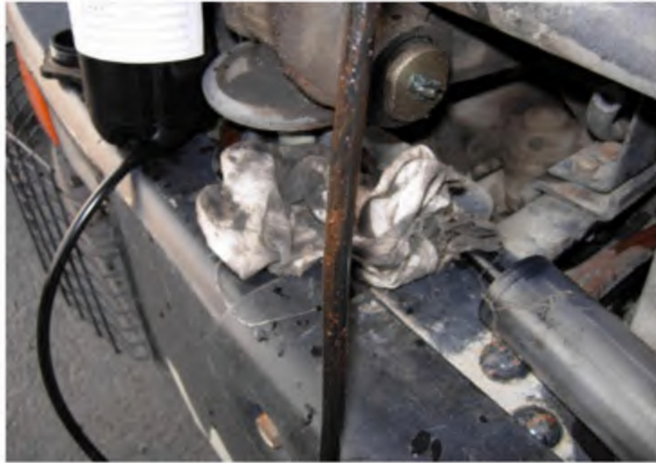
Рисунок 4.20 – Конденсат со следами ржавчины на трубке пробозаборника, извлеченного из маслозаливной горловины
