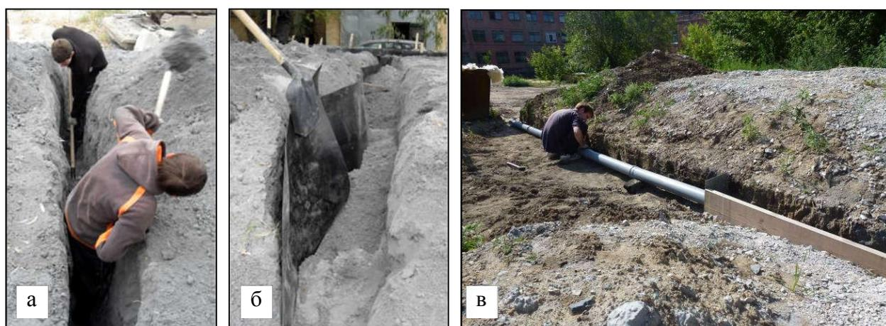
Рисунок 4.6 – Укладка геомембраны и водоотводного лотка: 1 – устройство прорези в поперечном направлении на всю высоту насыпи; 2 – укладка геомембраны с засыпкой и уплотнением ЗШС; 3 – устройство лотка с отведением воды в трубу
