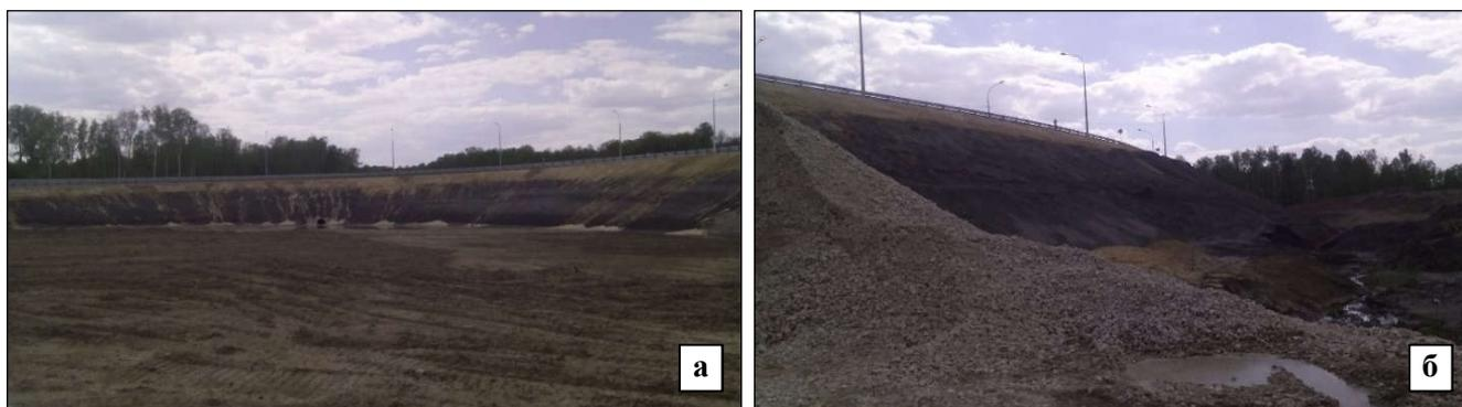
Рисунок 4.20 – Последствия оставления откосов без защиты в зимний период:
