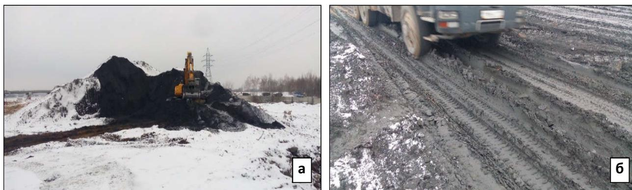
Рисунок 4.23 – Строительство на объекте в ноябре 2016 г.: а – разработка бурта экскаватором; б – последствия избыточной влажности ЗШС
