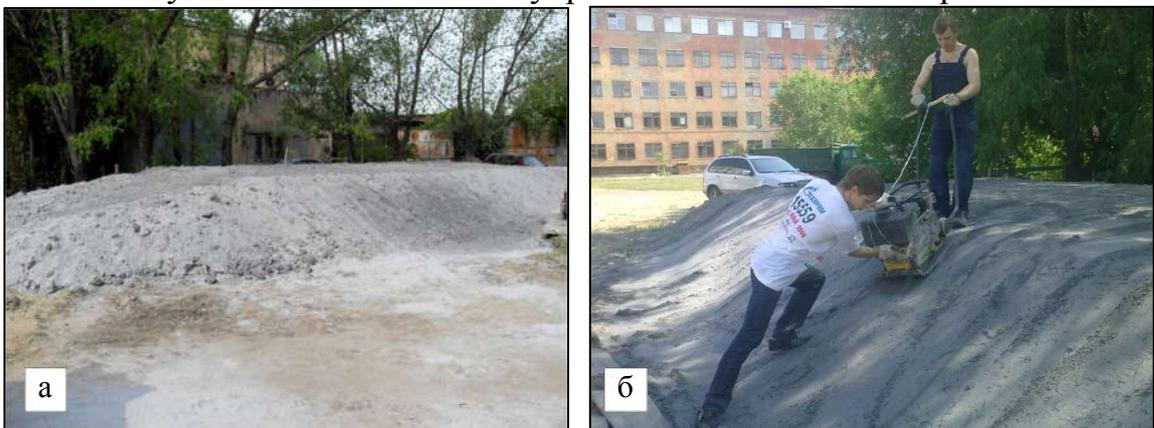
Рисунок 4.4 – Сооружение насыпи: а – общий вид насыпи; б – уплотнение откосов
