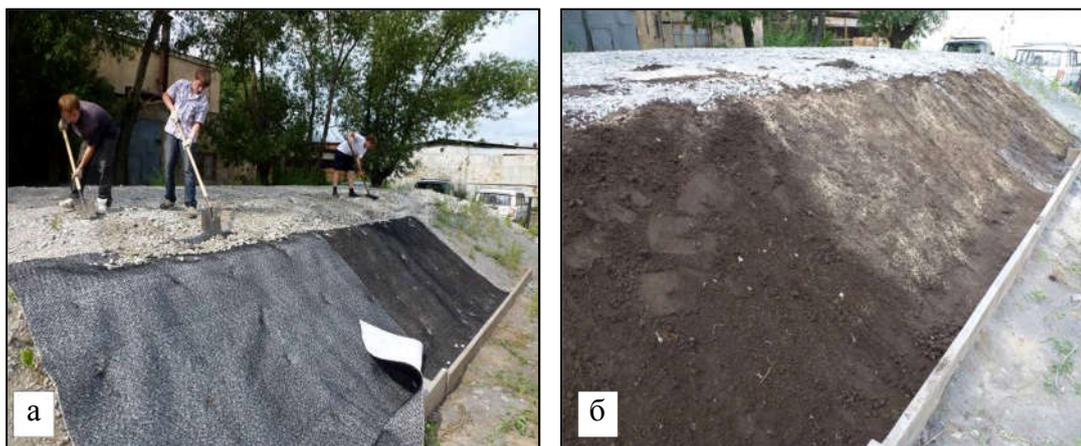
Рисунок 4.5 – Укрепление правого откоса насыпи: а – укладка полотен геоматов; б – устройство плодородного слоя грунта с посевом трав поверх геоматов и откоса из ЗШС
