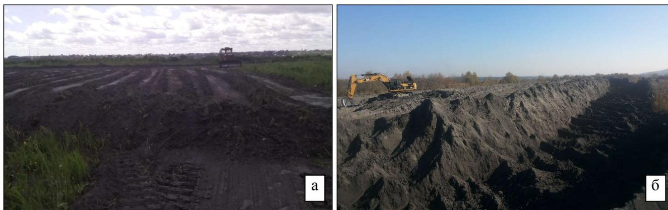
Рисунок 4.22 – Подготовка отвала к разработке: а – сдвигка растительного слоя; б – уборка глинистых включений.
