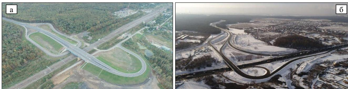
Рисунок 9 – Фотографии объектов с земляным полотном из ЗШС: а – развязка с насыпью из ЗШС Каширской ГРЭС-4; б – развязка с насыпью из ЗШС Дзержинской ТЭЦ-22
