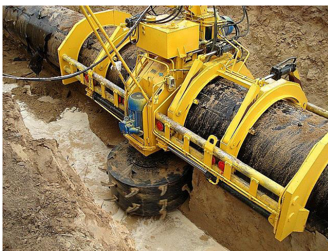
Рисунок 1.2 – Роторная машина для разработки грунта под трубопроводом
