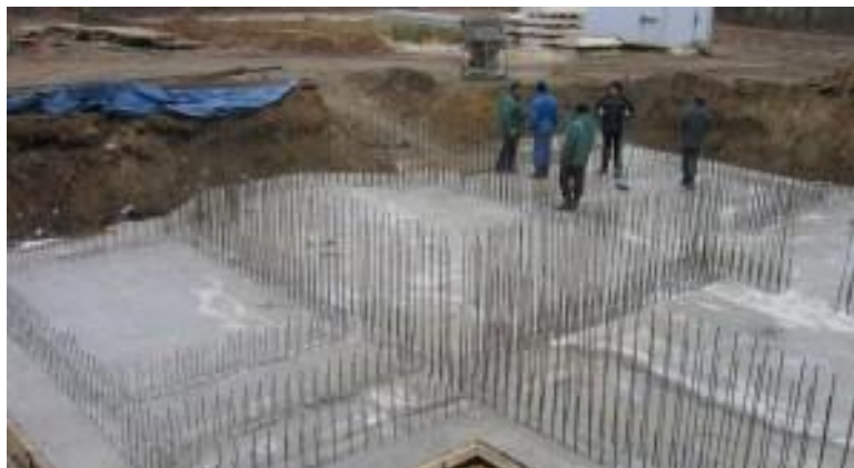
Рисунок 1.3 - Железобетонный фундамент с выпусками
