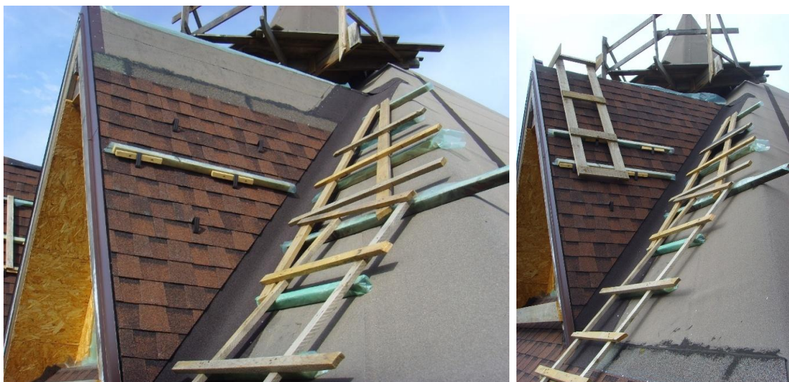
Рисунок 2 – Использование бугельных снегозадержателей в качестве средств обеспечения комфорта и безопасности кровельных работ
