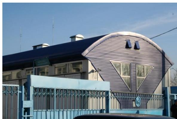
Рис. 1. Примеры конструкций бескаркасных цилиндрических покрытий в строительстве
