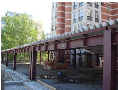
Рис. 2. Пример объекта с нерациональным решением опорных балок бескаркасных цилиндрических покрытий
