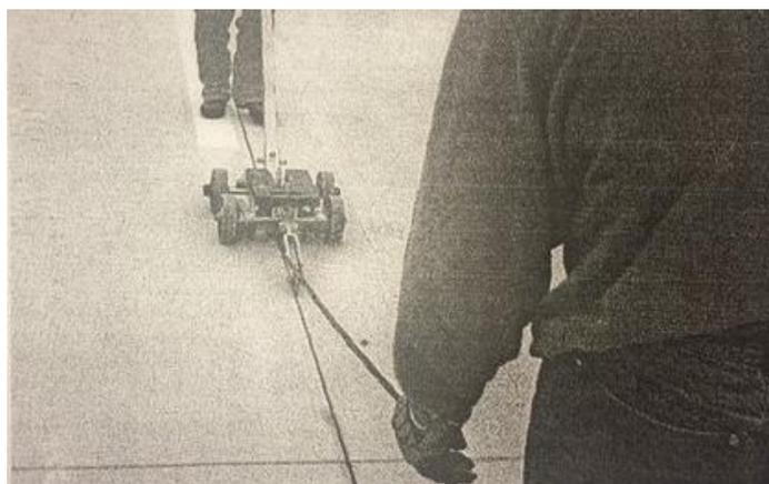
Рис. 4. Ручное устройство для заполнения деформационного шва
