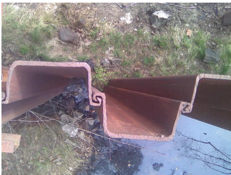
Рис.1. Ограждение из тяжелого шпунтового профиля типа Ларсен
