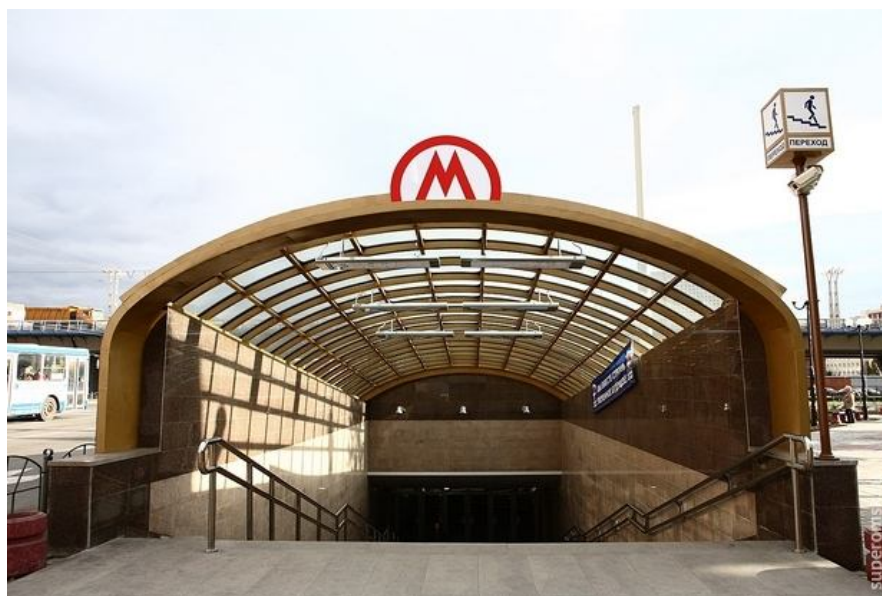
Рис. 7. Вид входа на станцию метро «Библиотека Пушкина»
