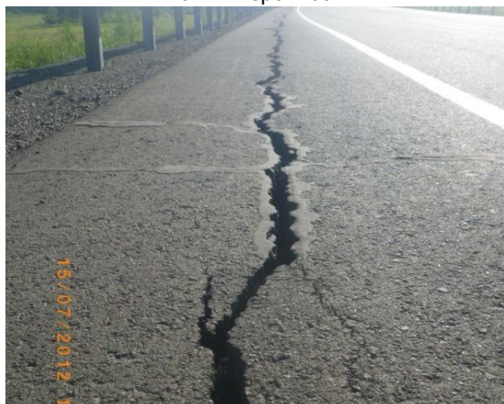
Рис. 2 . Продольная трещина на укрепленной обочине при просадке земляного полотна
