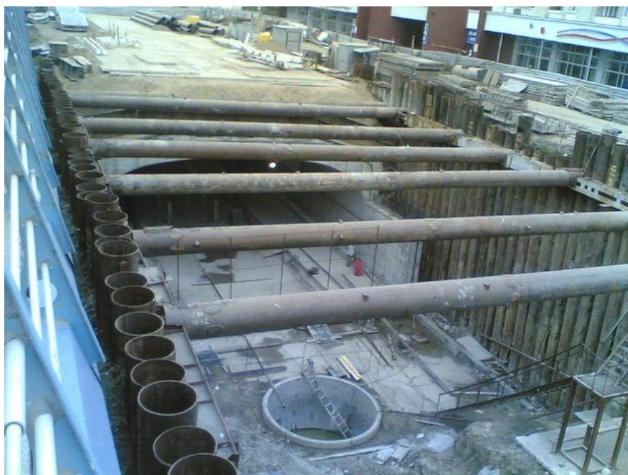
Рис. 6. Шпунтовая стенка с распорками на ст. «Библиотека Пушкина»
