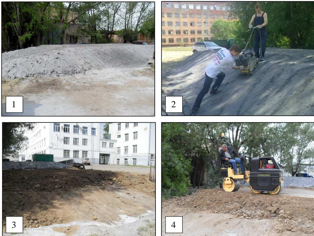
Рисунок 51 – Сооружение насыпи из золошлаковой смеси и суглинка:
