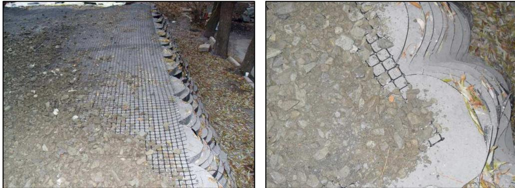
Рисунок 58 – Укладка геосетки под щебеночное основание
