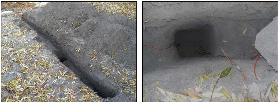
Рисунок 56 – Укладка термокосы в тело земляного полотна из ЗШС
