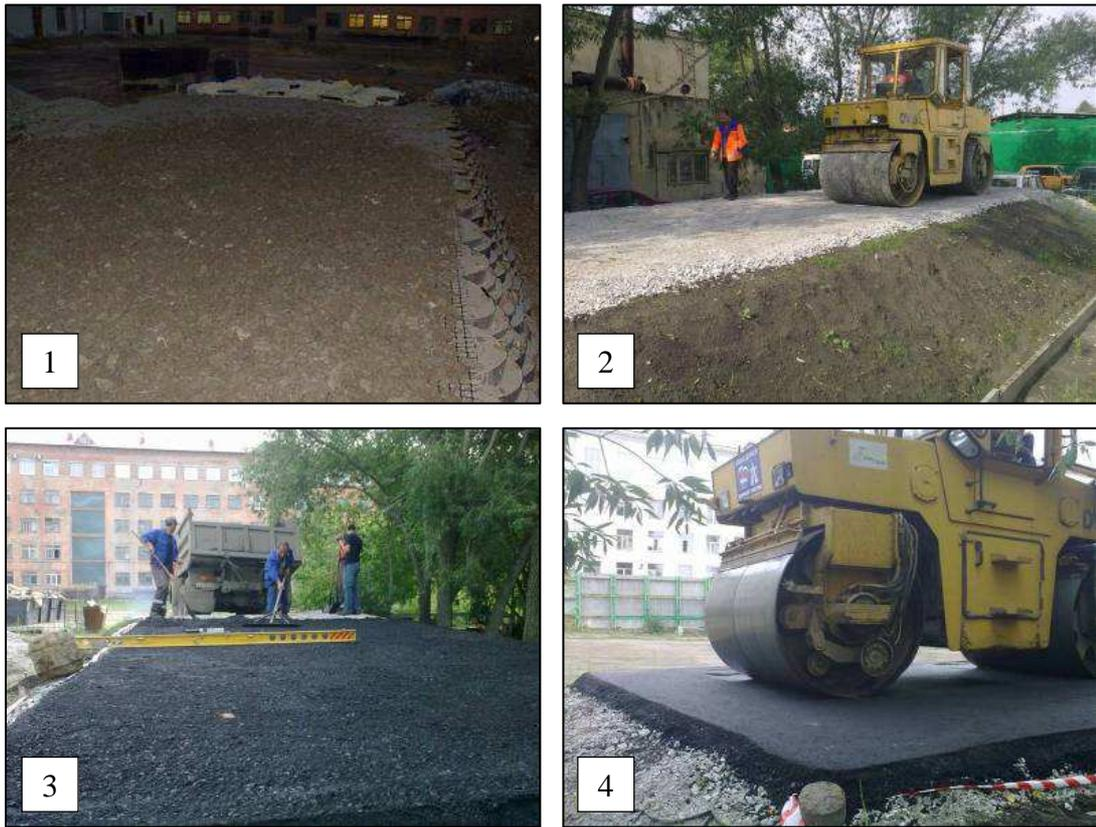
Рисунок 57 – Строительство дорожной одежды на опытном участке: 1, 2 – строительство слоя основания из ЦПС; 3, 4 – устройство асфальтобетонного покрытия
