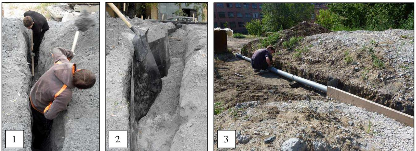
Рисунок 54 – Укладка геомембраны и водоотводного лотка: 1 – устройство канавы в поперечном направлении на всю высоту насыпи; 2 – укладка геомембраны с засыпкой и уплотнением ЗШС; 3 – устройство лотка с отведением воды в трубу
