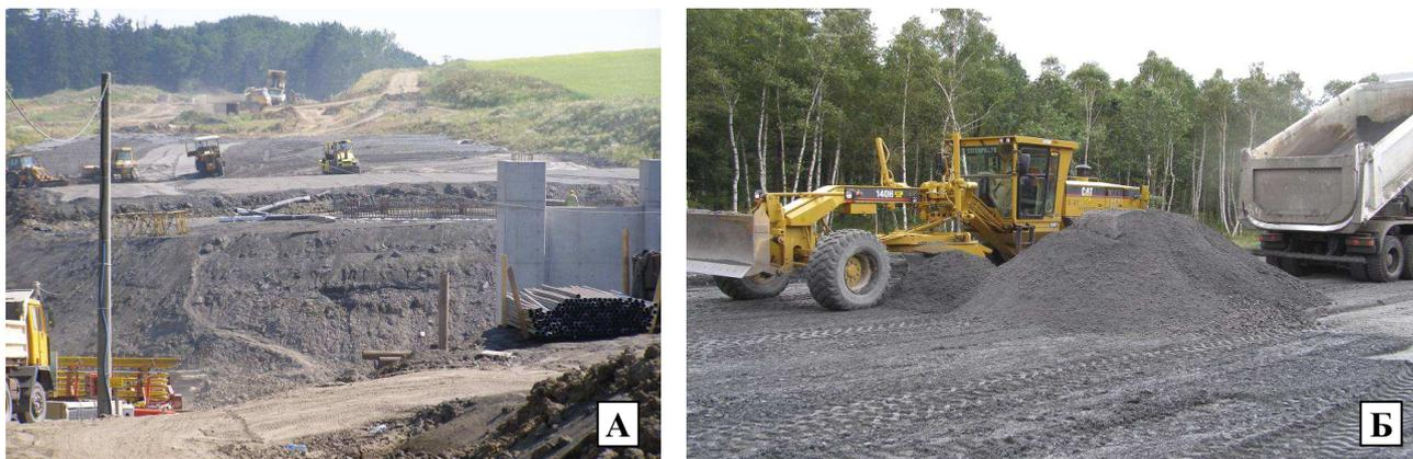
Рисунок 2 – Отсыпка высокой насыпи (А) и подстилающего слоя дорожной одежды (Б) из золошлаковой смеси (Польша)
