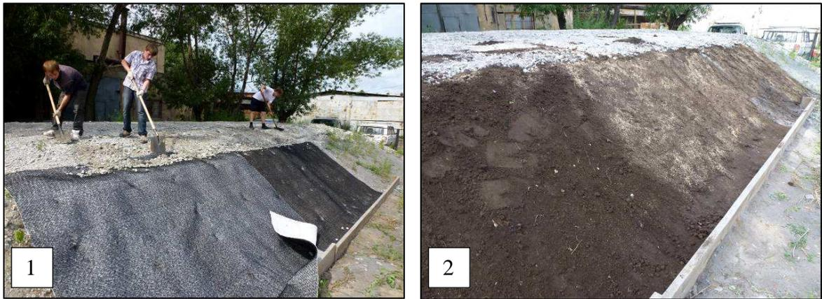
Рисунок 53 – Конструкции укрепления правого откоса насыпи: 1 – укладка полотен геоматов; 2 – устройство плодородного слоя грунта с посевом трав поверх геоматов и откоса из ЗШС
