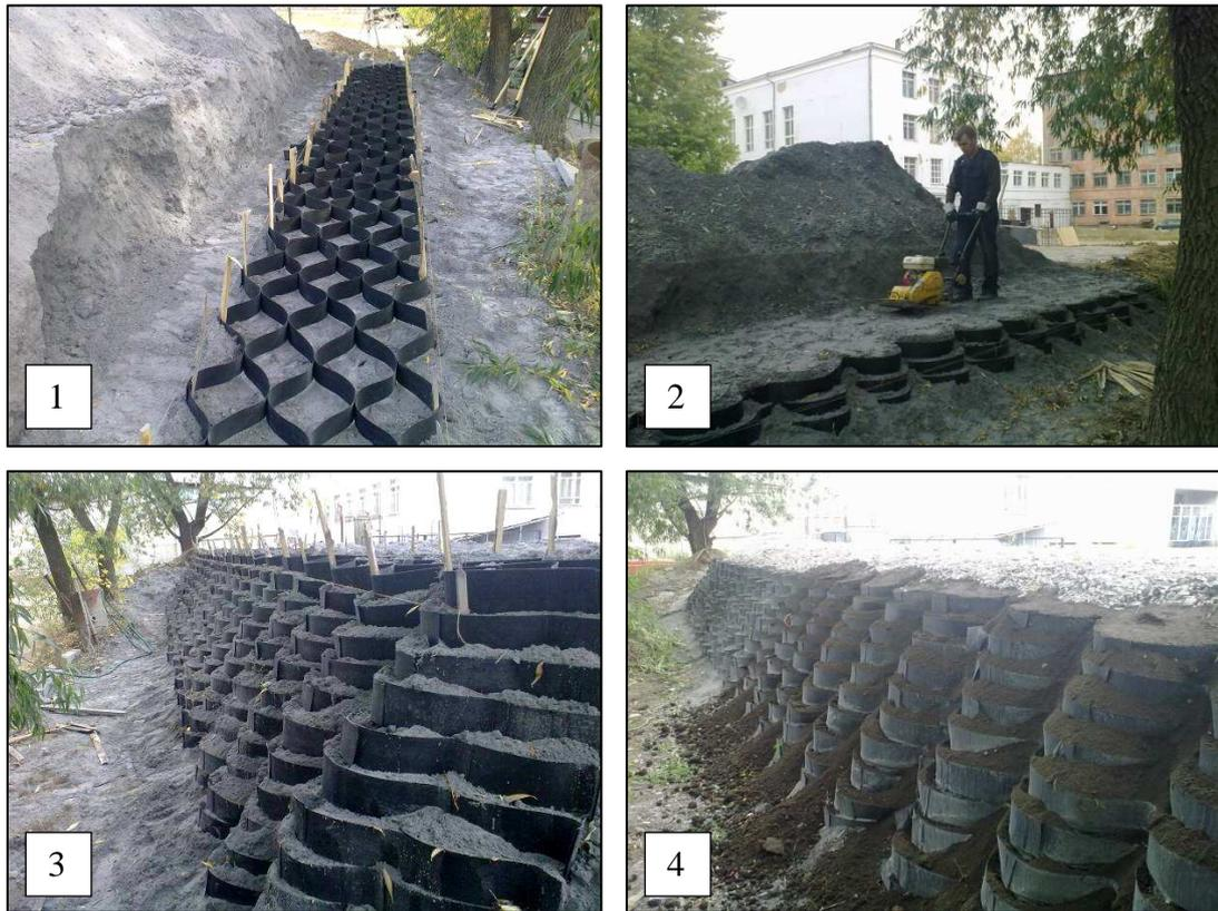
Рисунок 52 – Укрепление левого откоса насыпи:
