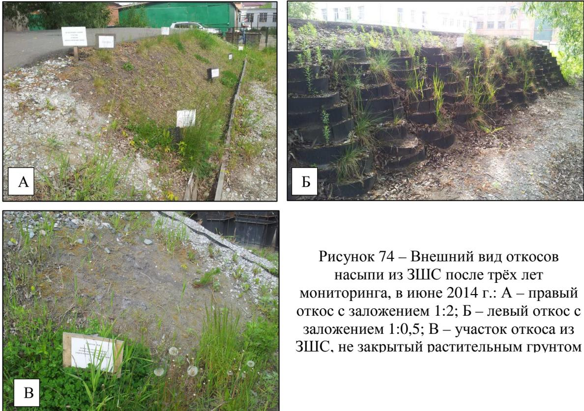
Рисунок 74 – Внешний вид откосов насыпи из ЗШС после трёх лет мониторинга, в июне 2014 г.: А – правый откос с заложением 1:2; Б – левый откос с заложением 1:0,5; В – участок откоса из ЗШС, не закрытый растительным грунтом
