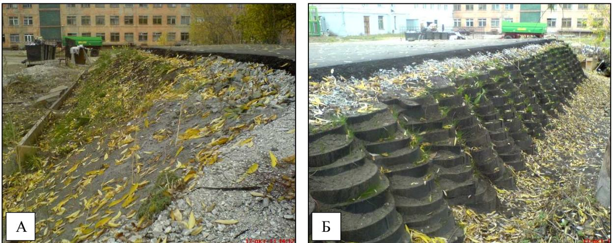
Рисунок 73 – Внешний вид откосов насыпи из ЗШС в октябре 2011 г.: А – правый откос с заложением 1:2; Б – левый откос с заложением 1:0,5 (обозначение откосов соответствует рисунку 50)
