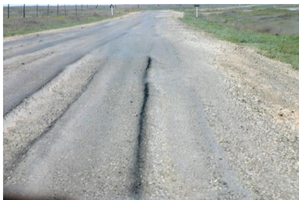
Рис. 1. Поверхностная колея на покрытии, сопровождаемая выпором асфальтобетона
