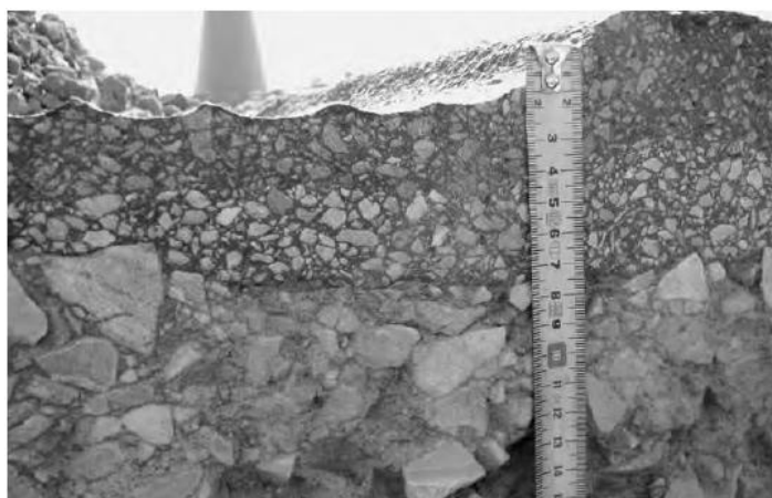
Рис. 3. Измерение глубины поверхностной колеи в верхнем и нижнем слое покрытия, сопровождаемой выпором асфальтобетона
