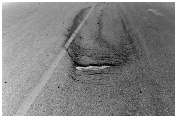
Рис. 2. Поверхностная колея на покрытии, сопровождаемая просадкой асфальтобетона
