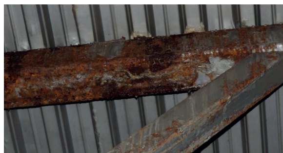
Рисунок 1 – Стропильная ферма из профильных труб: а – общий вид на ферму; б – коррозионные повреждения элементов фермы
