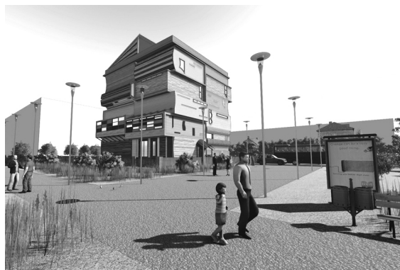
Рис. 1. Вид на юго-западный и главный фасады ЦРИГЗ
