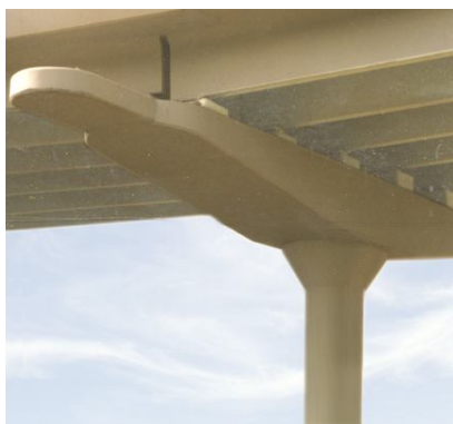
Рис. 1. Общий вид опоры моста
