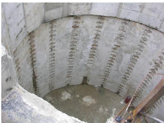
Рис. 5. Состояние несущих конструкций колодца на момент обследования
