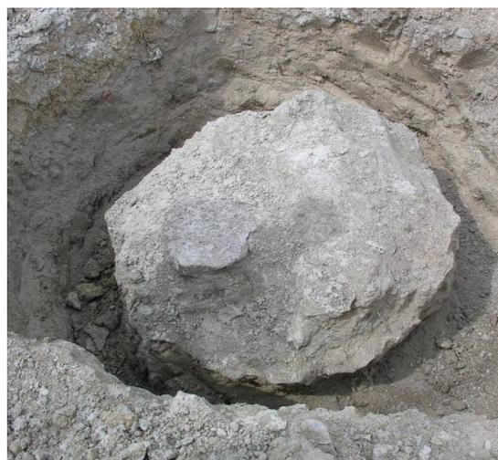
Рис. 4. Оголовок опытной колонны смеси грунта с цементом
