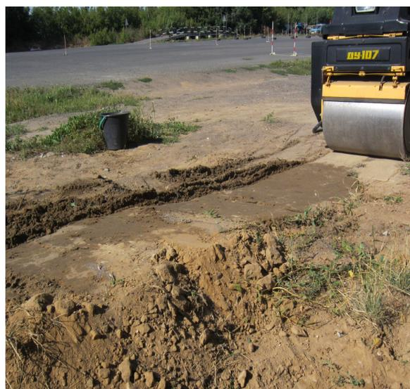
Рис. 5. Уплотнение супесчаного грунта вибрационным катком ДУ-107 (ЗАО Раскат)
