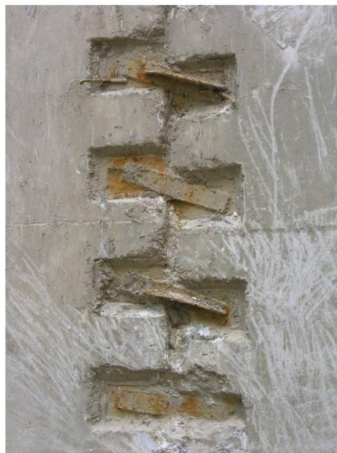
Рис. 6. Соединительные пластины приваренные с уклоном
